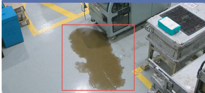
设备漏油漏水侦测
